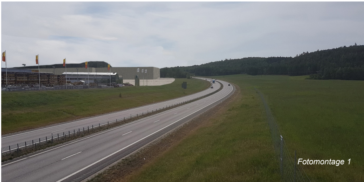
Foto 1 från norr längs väg E6
