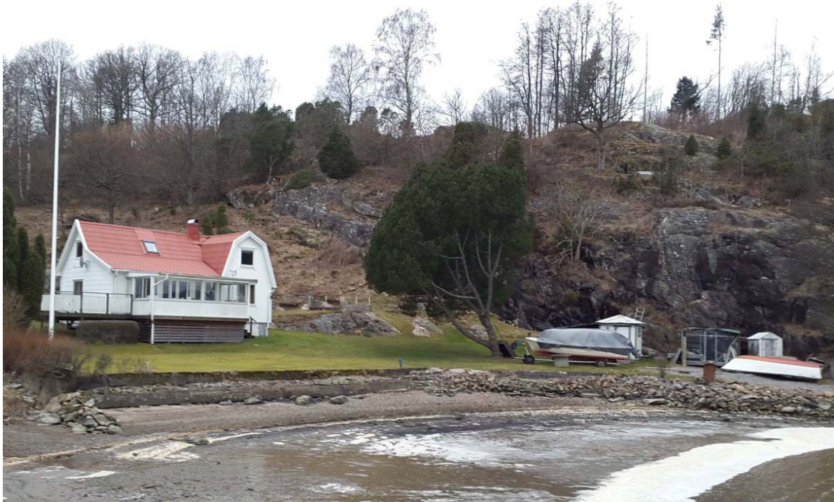
Exempel på brant bergslänt vid fastigheten Ödsby 1:4, längst ner i Solvik
