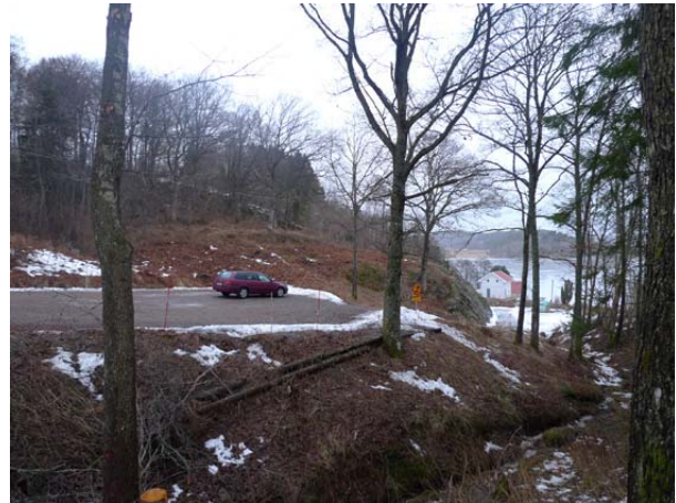
Vy nedre delen ravinen vid vändplatsen där en tryckbank anläggs.
