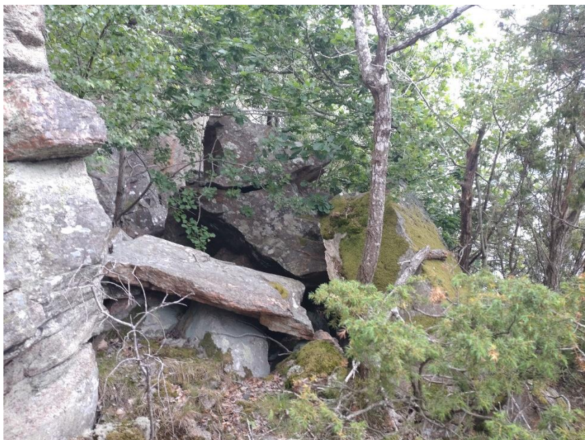
Figur 8. Exempel på hylla i slänten som fångar upp utfall.
