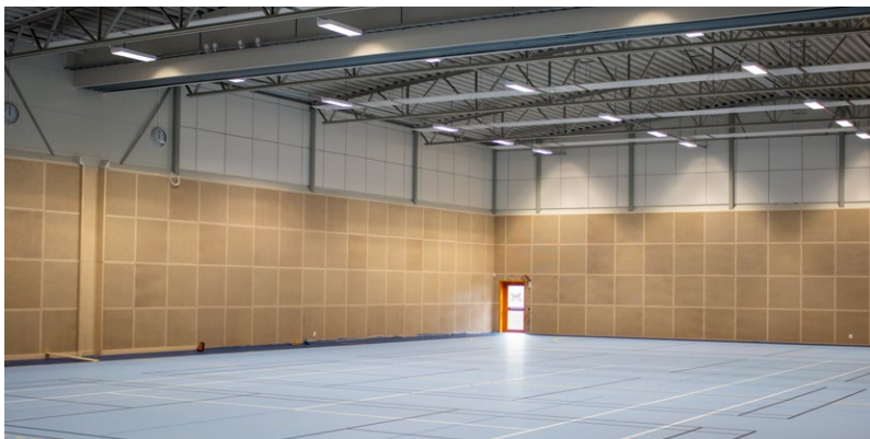
Insidan av den nya bollhallen börjar ta form och hallen beräknas stå klar under sommaren 2022.
