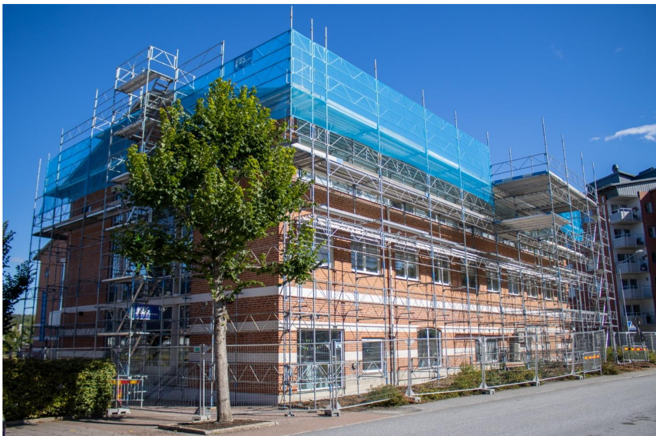
Under året påbörjades byte av tak och installation av solceller på kommunhuset – Foto: Erland Pållsson
