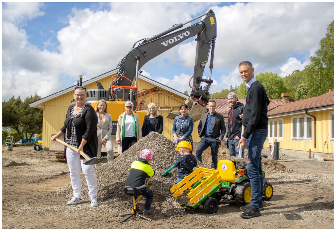
Första spadtaget för renovering och tillbyggnad av Dingle förskola, maj 2022 – Foto: Erland Pålsson
