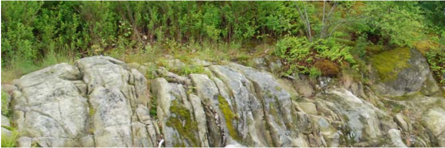
Bergsslänt i anslutning till Thorildsplatsen.
