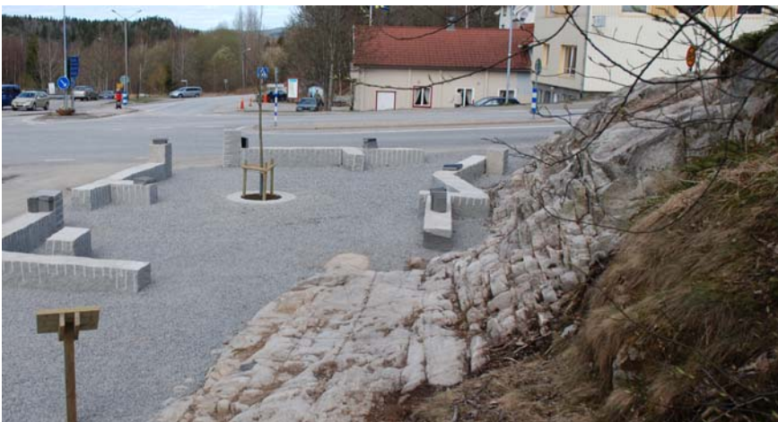
Bergsslänt i anslutning till Thorildsplatsen.
