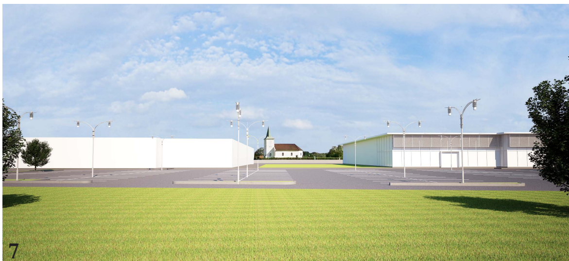
Vy från E6, mellanrummet mellan byggnaderna
