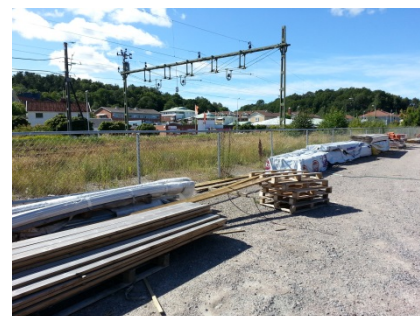
Vy mot spårområdet vid Bohusbanan
