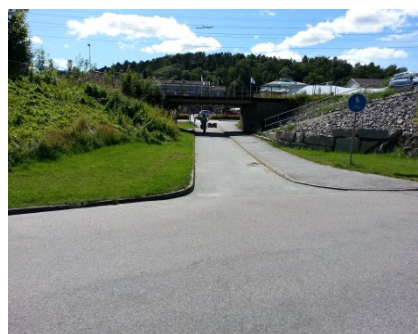
GC-tunnel mellan Vadholmsvägen och Strömstadsvägen
