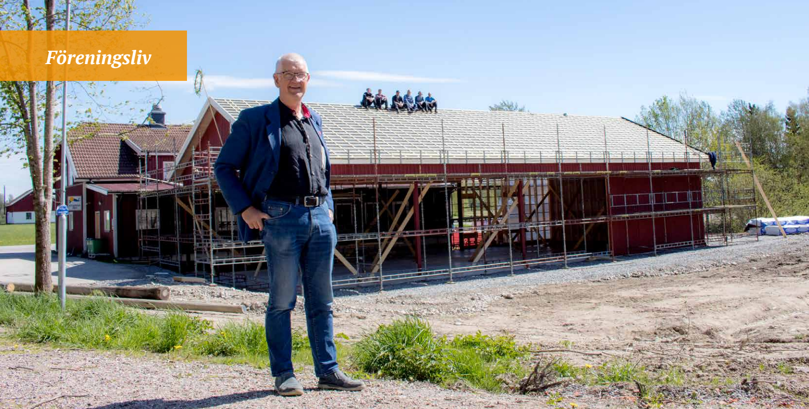
Rolf Berg, framför den pågående byggnationen av Arena Sörbygden i Hedekas.
