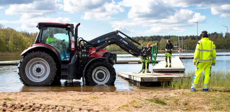
Iläggning av badbryggor i Hällevadsholm
