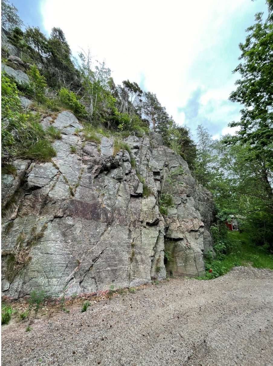
Figur 3. Detaljerade foton av blocket i Figur 2. Vy från norr.
