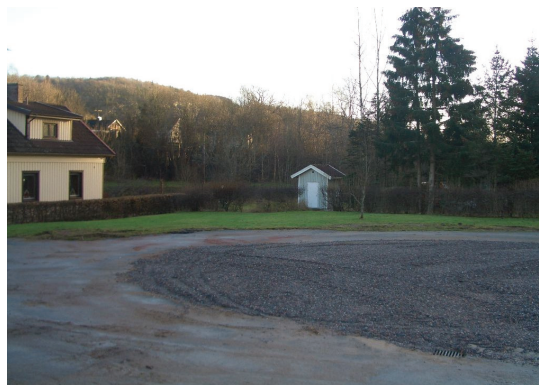
Pumpstationen utanför planområdets södra gräns
