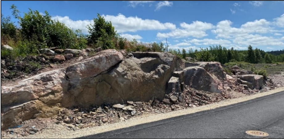
Figur 22. Del av bergskärning längs vägen genom området i den norra delen.
