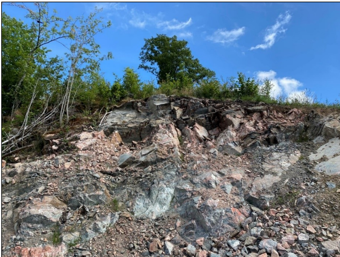
Figur 15. Norra delen av bergskärningen i det Västra området. Fotot taget i östlig riktning från den västra del av området
