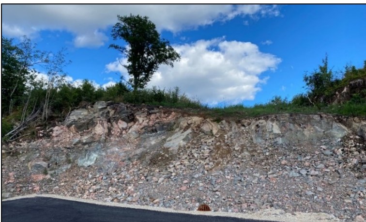
Figur 14. Bergskärning i det Västra området. Fotot taget i östlig riktning från den västra del av området
