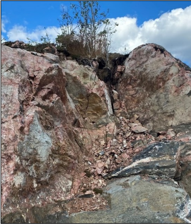
Figur 25. Detalj av bergskärningen i södra delen av Östra området
