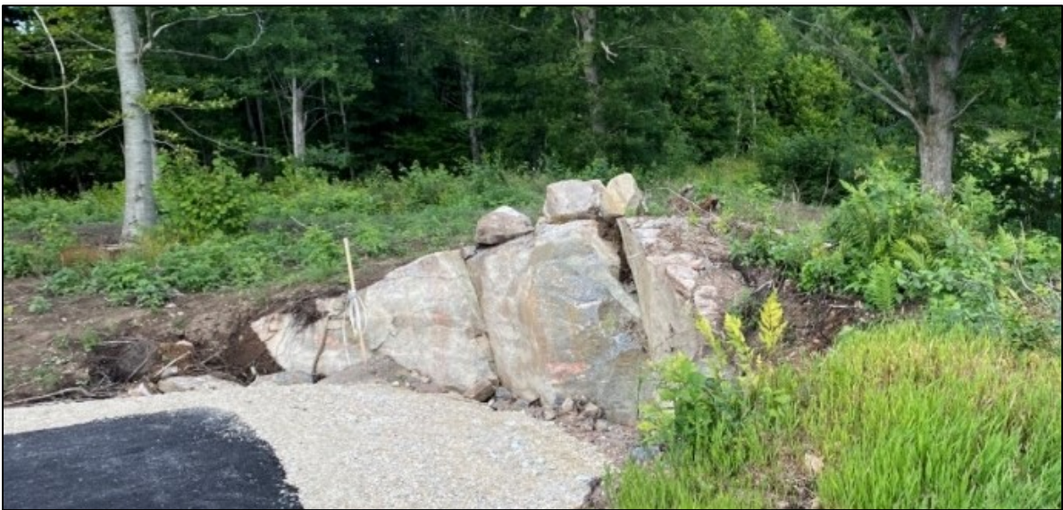
Figur 26. Större block på mindre bergskärning i norra delen av Östra området
