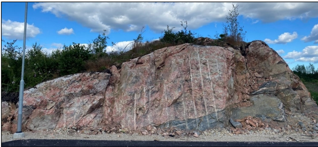
Figur 20. Bergskärning i södra delen av Östra området. Bergskärningen går i nordvästlig
