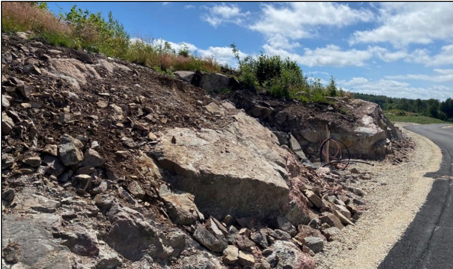
Figur 23. Del av bergskärning längs vägen genom området i den norra delen
