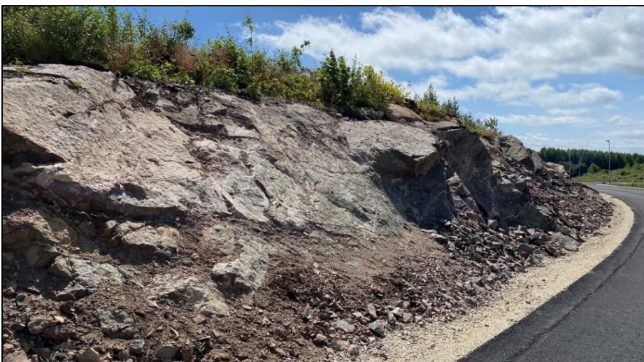
Figur 24. Del av bergskärning längs vägen genom området i den norra delen.
