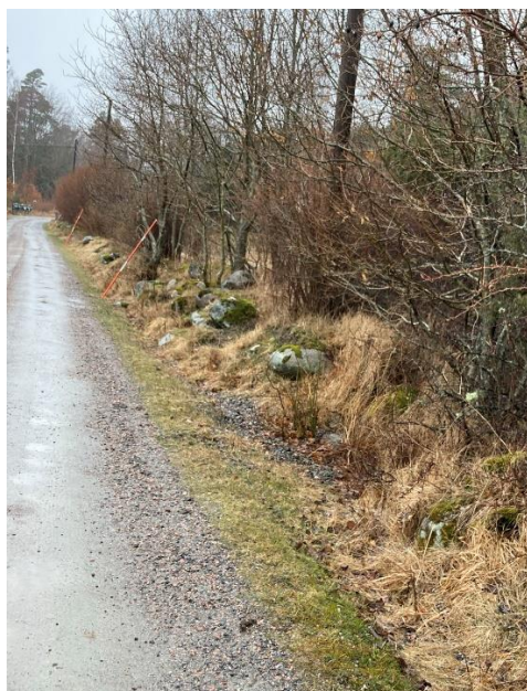
Figur 4. Dike utmed nordöstra sidan av Bergsviksvägen.
