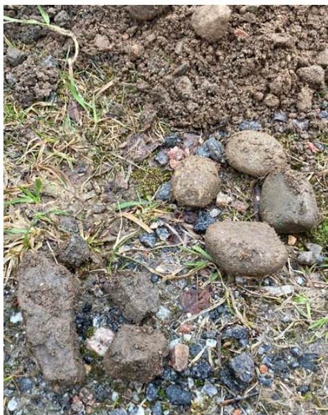
Figur 1. Fraktioner som kom fram vid okulärbesiktning av Bergsviksvägen.
