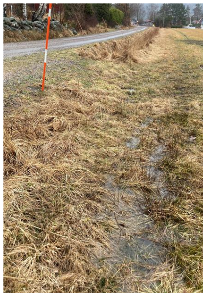
Figur 2. Dike mellan Bergsviksvägen och planerat område Ängen
