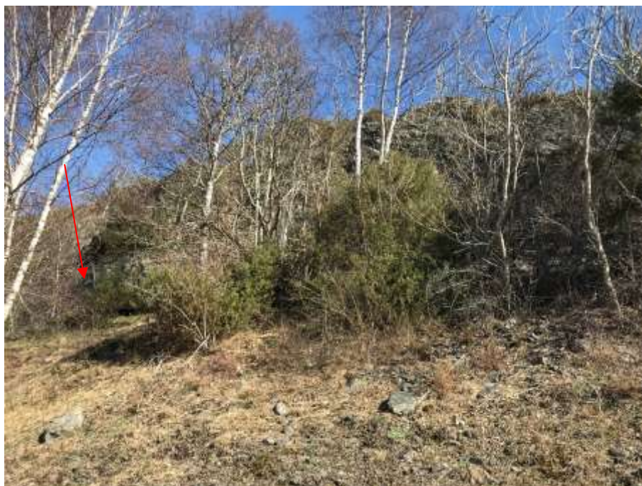
Figur 3. Bild tagen från väg 832: nederst jord-/blockslänt som övergår i en 20 m hög bergsbrant. I vegetationen skymtas skyddsstaketet (röd pil).
