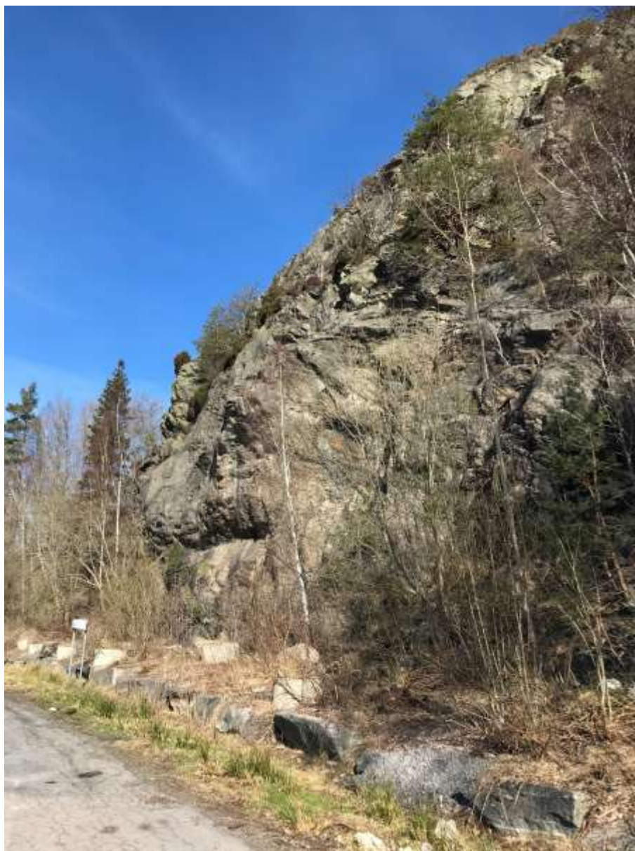
Figur 4. Den ca 40 m höga bergsbranten vid kontrollplatsen. Block i släntfot har placerats där och inga uppenbart nedfallna block observerades.
