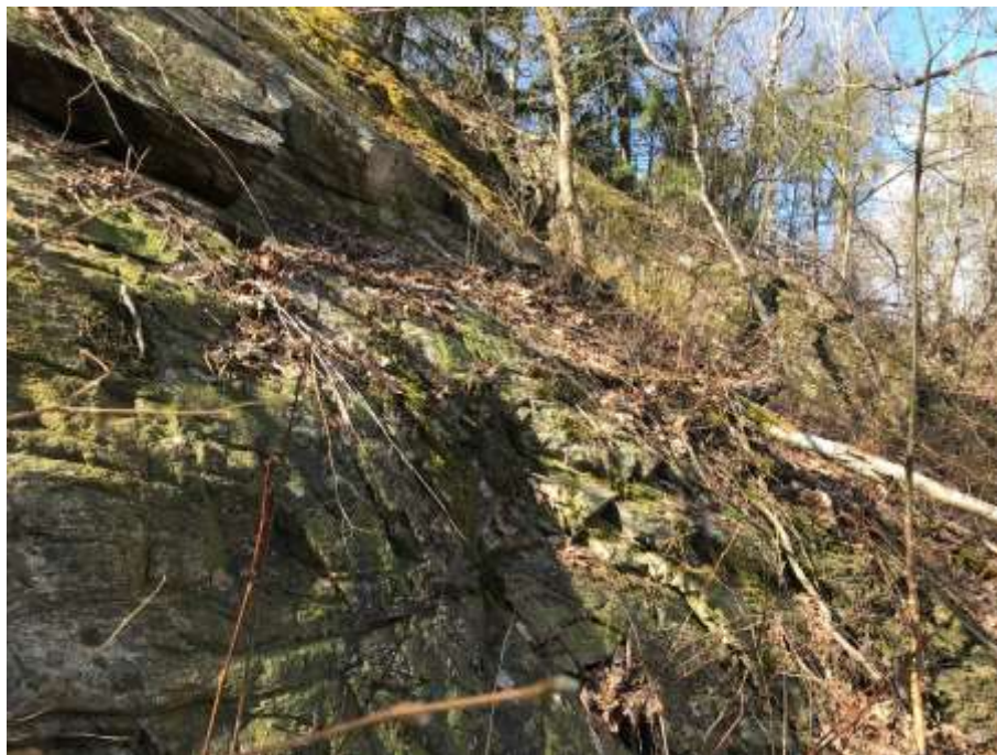
Figur 8. Blottat berg i detaljplaneområdets sydöstra del, med släntsida och utglidande skivor som bildas av sprickgrupp 1. Bild tagen mot norr.
