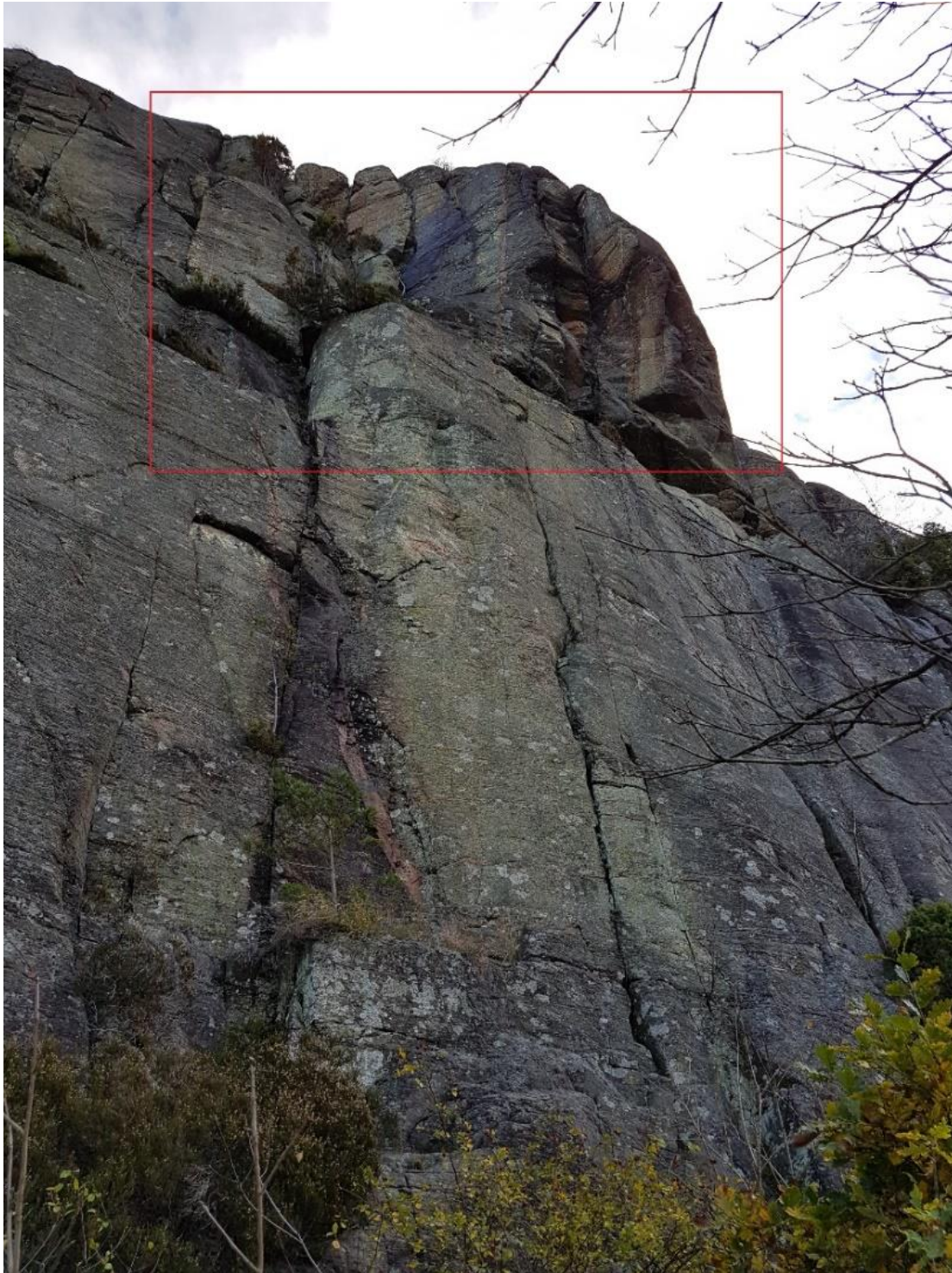
Figur 1. Överhängande block med sprickor som skapar mindre potentiella block i anslutning till fastighet 3:51. Vatten finns vid sprickor och en blockansamling ligger nedanför slänten, se röd markering.
