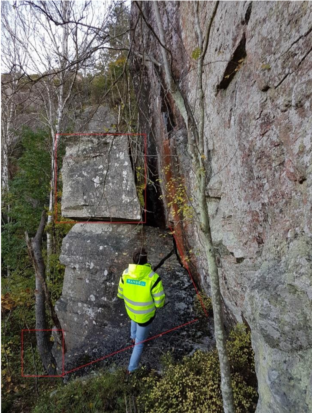
Figur 9. Block med öppna sprickor som har stabiliserat med ett block ovan, se röd markering. Blocket har flyttat sig och är i kontakt med ett träd vid nedre delen. Trädet växer vid sprickor som ligger i botten av blocket. Sprickor förekommer på båda sidor av blocket.
