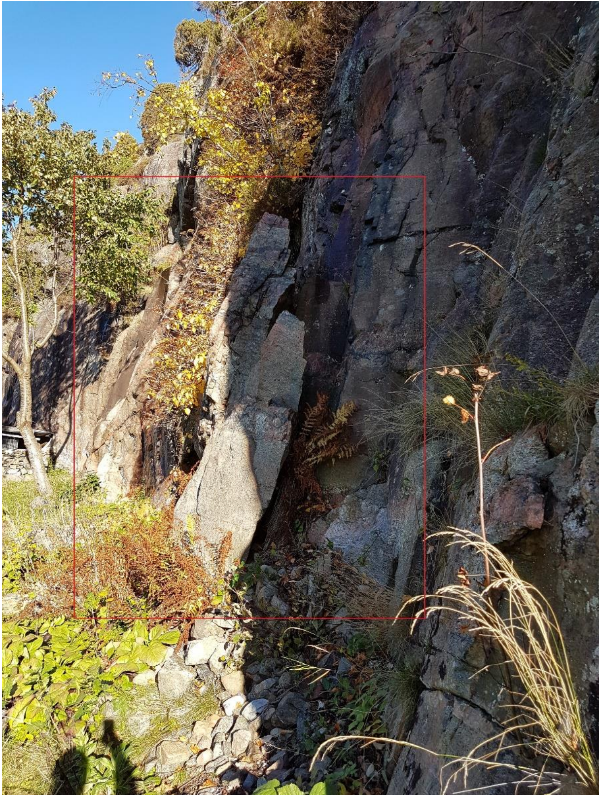
Figur 5. Blockansamling nedan slänten invid fastighet 3:2, se röd markering. Växtlighet och vatten finns vid väggen som kan fortsätta att orsaka blockutfall.
