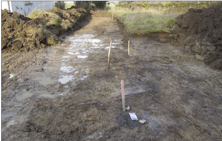
Figur 27. Översiktsbild över ett urval av anläggningarna i schakt S399. Foto: Bengt Nordqvist.
