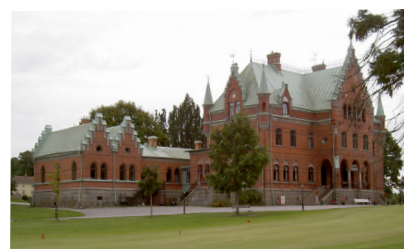
Bild 3. Huvudbyggnaden på Torreyby slott är belägen 150 meter söder om planområdet.
