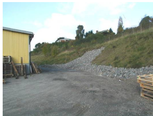
Förstärkningsåtgärder efter skred bakom Sohlbergs byggvaruhandel
