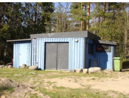
Befintlig byggnad vid vattenverket.
