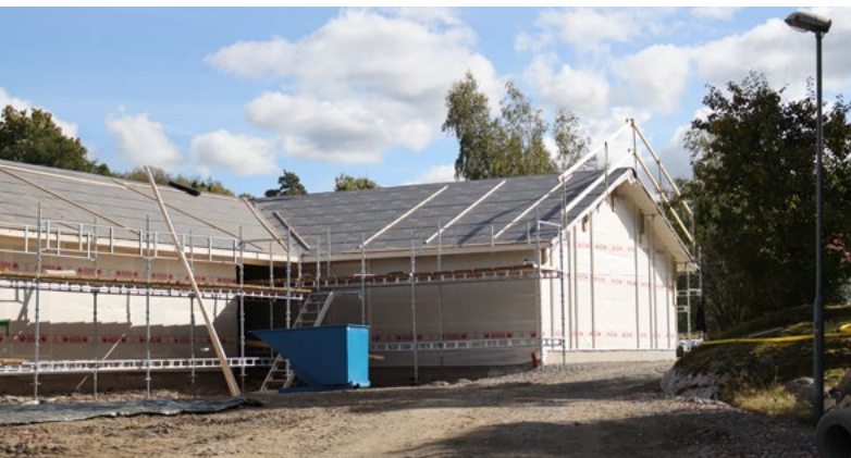
Förskolan i Dingle renoveras och byggs ut.
