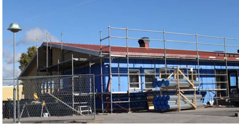
Renovering av Hedekas förskola pågår.
