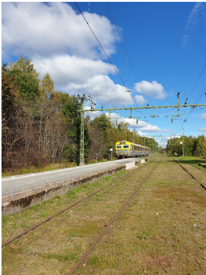
Figur 16 Sidplattform till det genomgående spåret med ankommande tåg. Underhållssticket ligger på andra sidan plattformen och slutar i en stoppbock innan gångvägen till plattformen. Bilden visar den gamla plattformen, innan arbete genomfördes sommaren 2023.
