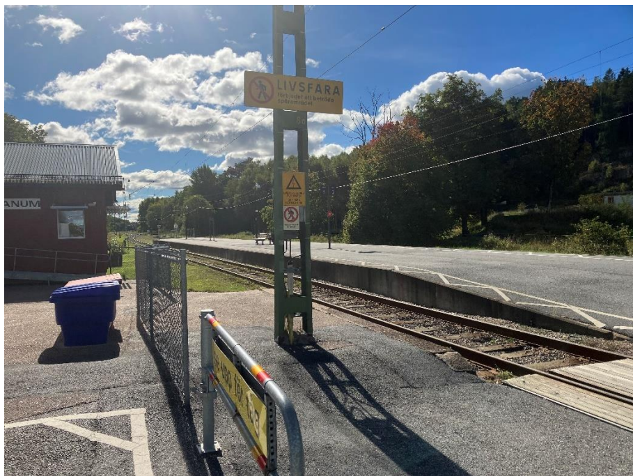
Figur 19 En plattformanslutning leder över spår 1. Plankorsningen är obebakad. Spår 2, vilket är det genomgående spåret, används i huvudsak förutom vid tågmöten då även spår 1 används.
