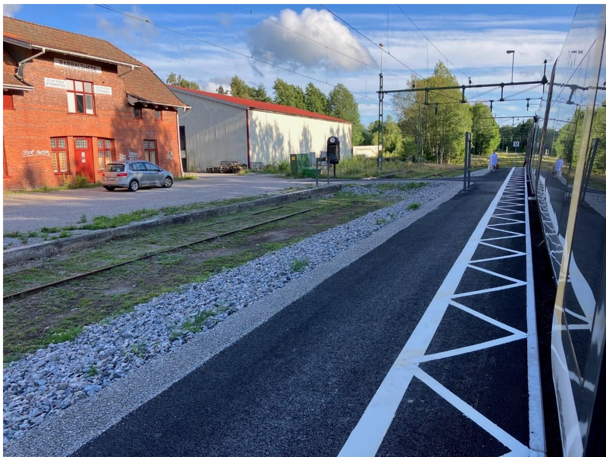
Figur 15 Det finns ett spår och ett underhållsstick Rabbalshede. Plattformen har säkerhetszon.
