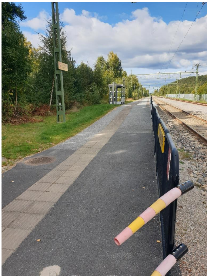
Figur 29 Relativt nybyggd plattform. Den enda plattformen längs banan som har ledstråk.
