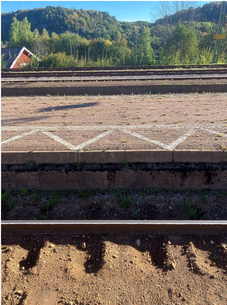
Figur 9 Mittplattform och spår 1. Bilden är tagen från sidoplattform för genomgående spår 1.
