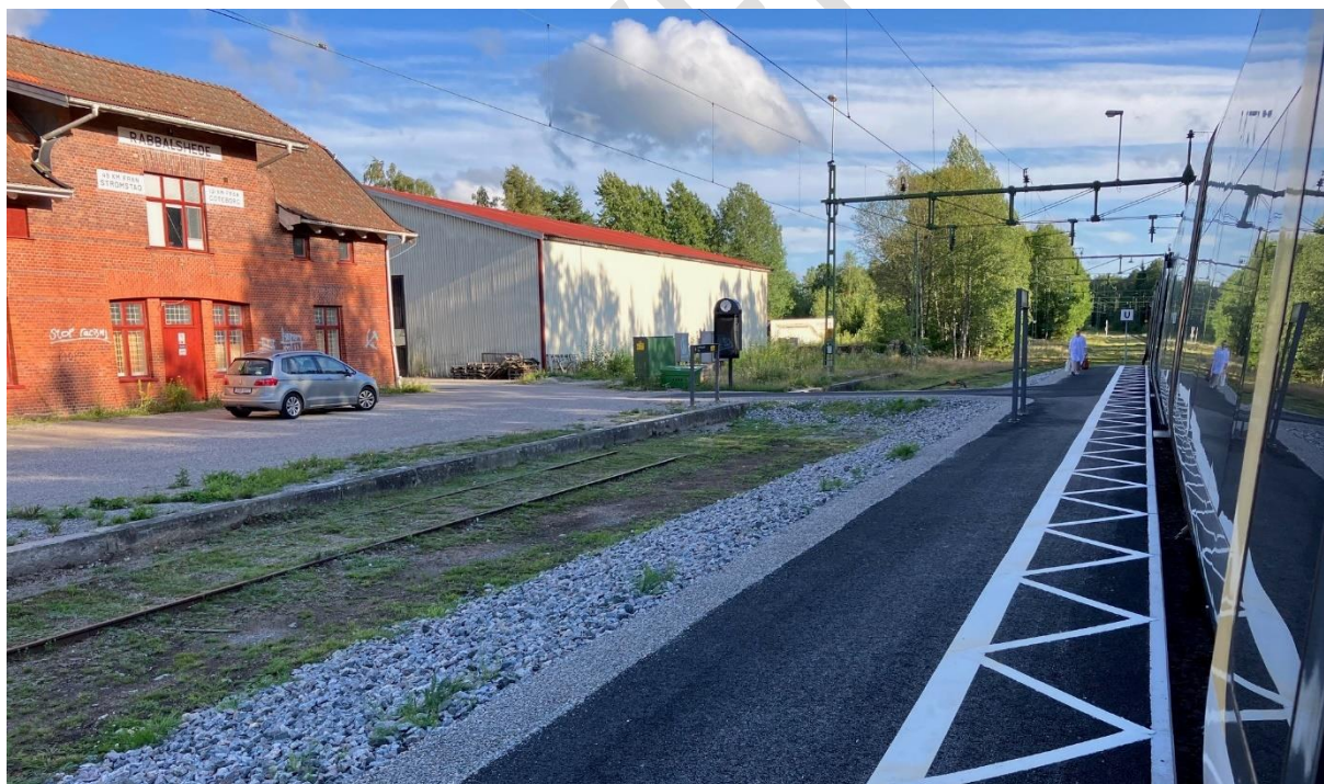
Figur 41. Plattformen i Rabbalshede har nyligen förbättrats för resenärer, men kräver åtgärder om tågmöten ska möjliggöras (åtgärd 36).
