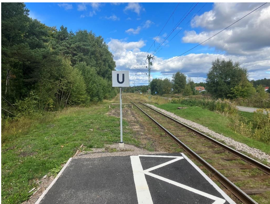
Figur 22 Rester av gamla spår och gammal plattform syns norr om den nya plattformen.
