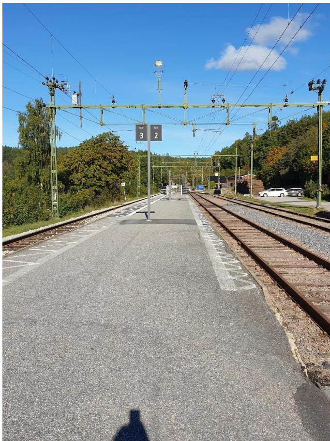
Figur 11 Mittplattform till spår 2 och spår 3. Spår 3 är genomgående. Väster om spår 3 sluttar marken brant nedåt mot samhället och längs med spår 3 går stängsel för att förhindra spårspring.
