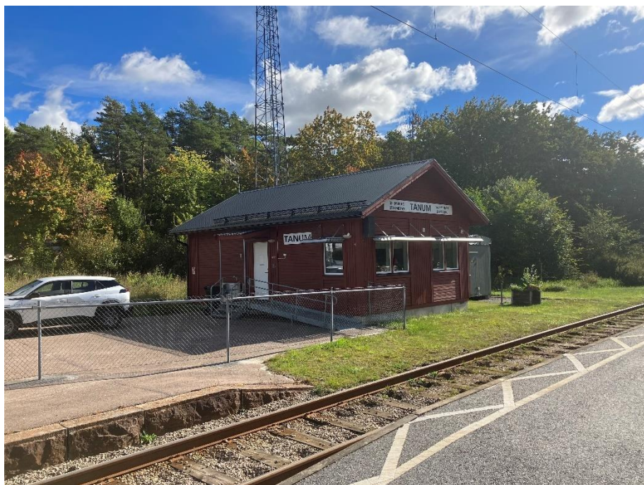
Figur 20 Hus för Trafikverkets personal ligger intill spår 1.
