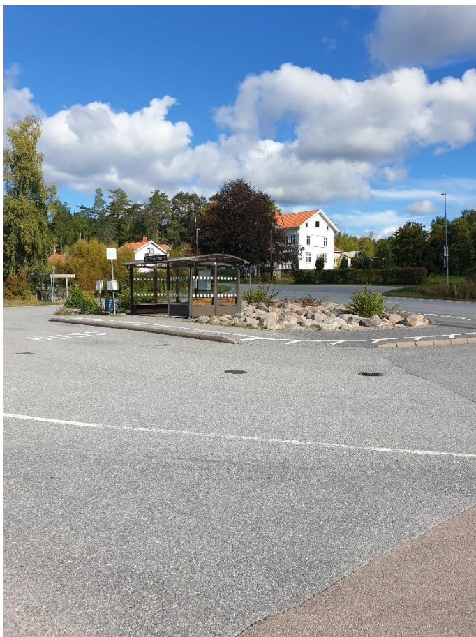
Figur 17 Där busshållplatsen ligger idag låg det gamla stationshuset som revs på grund av svampangrepp.
