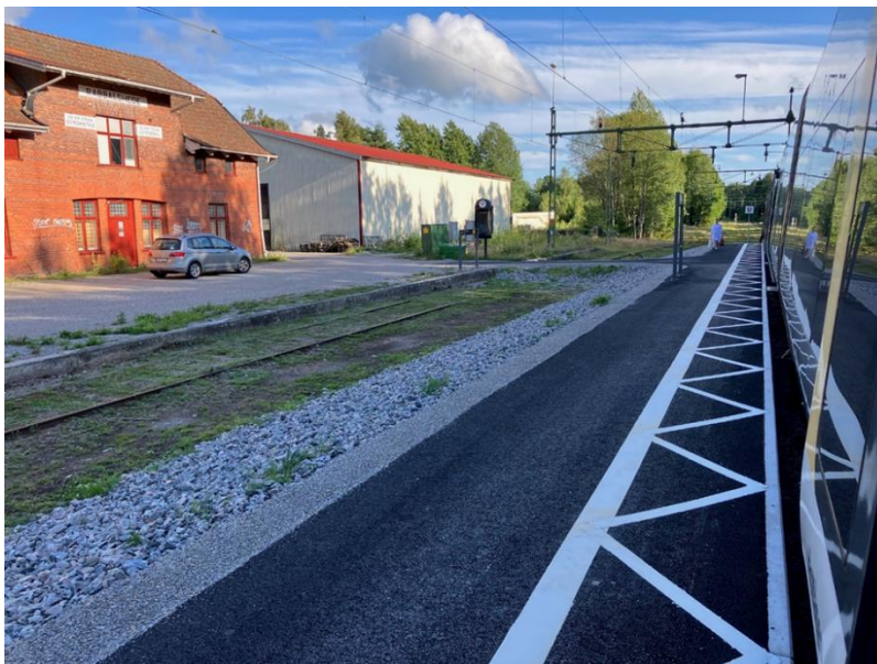
Figur 1 Befintlig plattform i Rabbalshede, upprustad under sommaren 2023.
