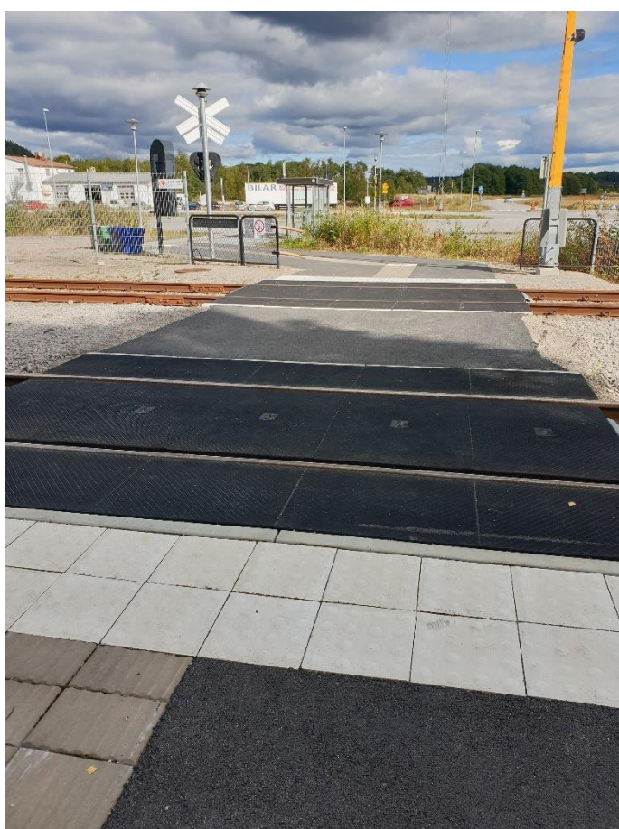
Figur 28 Plankorsning över två spår för att komma till plattformen.
