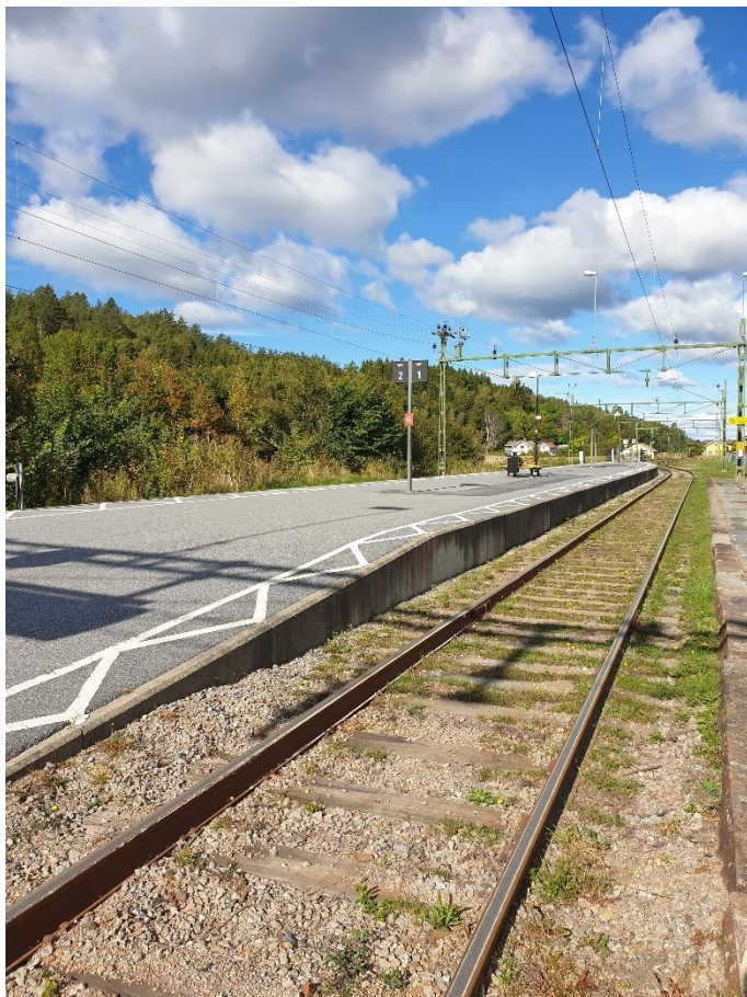
Figur 18 Spår 1 och mittplattformen. Plattformen har utmålade säkerhetszon. Ruderatytor i spåren.
