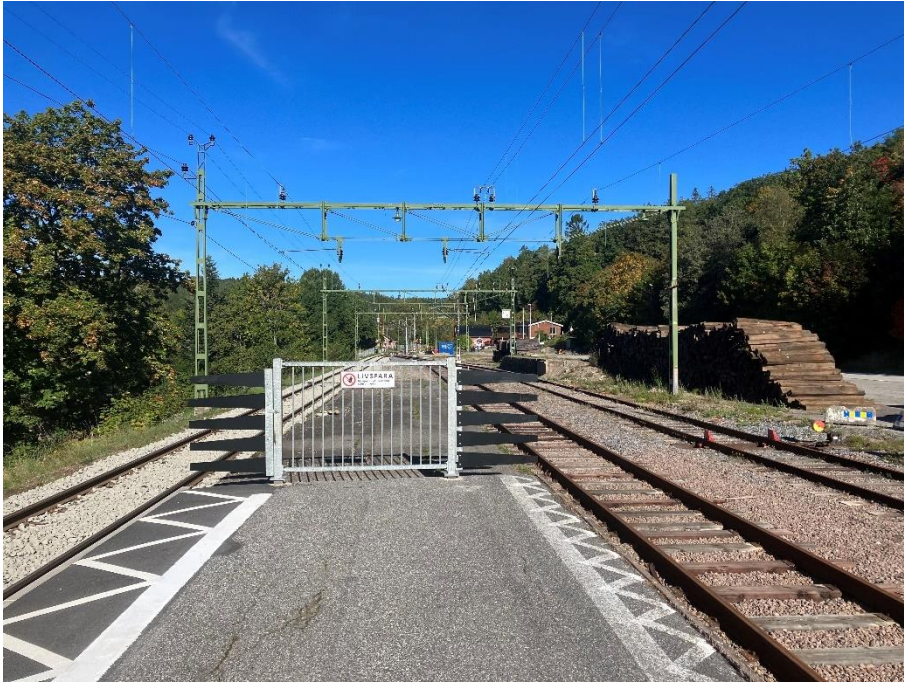
Figur 5 Del av mittplattformen är avstängd med grind och "hajfenor".
