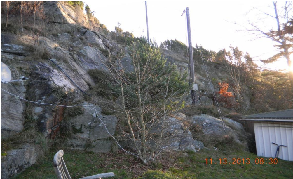
Figur 9: Lössprucket berg risk för nedfallande stenblock
