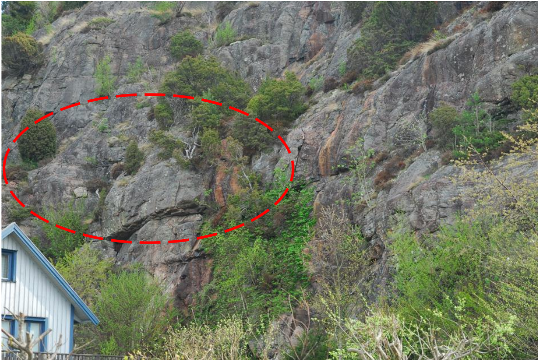
Bild 9. Löst block ca 5 meter upp i slänten. Fastighet 3:2.
