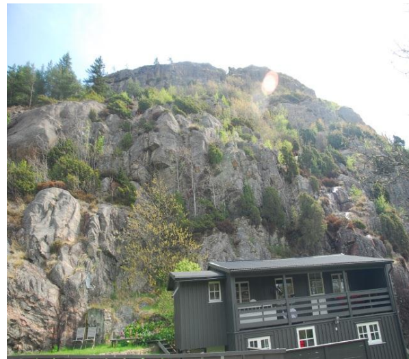
Bild 35. På väg till fastighet 3:19. Stora lösa block och mycket vegetation i sprickor som riskerar att trycka ut blocken.
