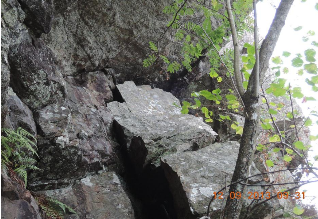
Bild 04. Block på väg att lossna ovanför fastighet 3:2 och 3:4.
