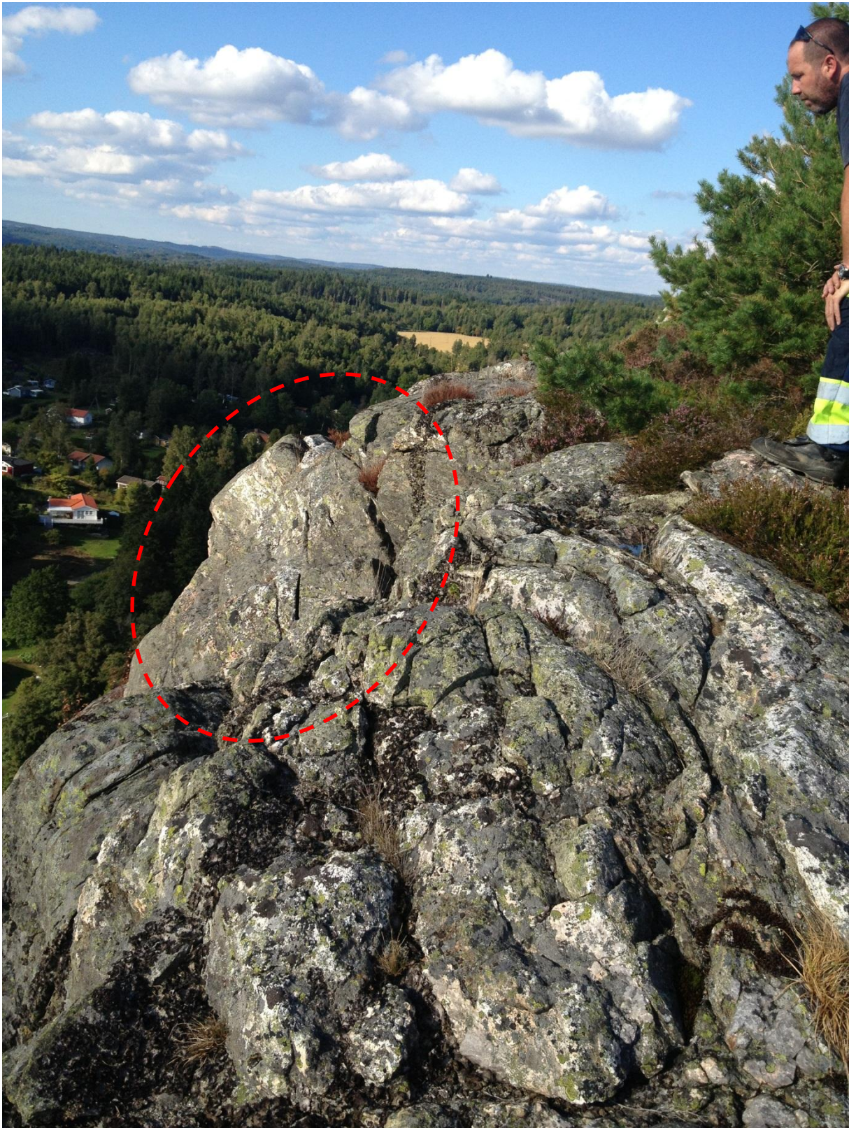
Bild 06. Vy ovanför fastighet 3:2 och 3:4 på ca 75-90 meters höjd där man ser naturliga sprickor och vittrat berg. En del partier riskerar att falla ner vilket riskerar att skada bebyggelsen nedanför.
