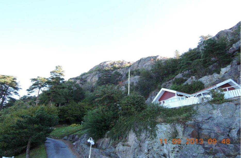
Bild 103. Bebyggelse på en ca 5 meter hög bergplatå nedanför medelbrant bergslänt vid fastighet 3:3.
