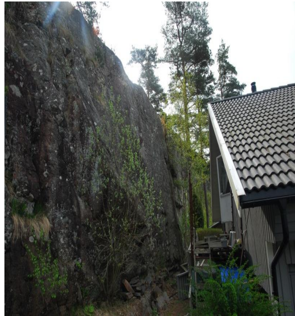
Bild 25. Fastighet 3:19. Nära befintlig byggnad.
