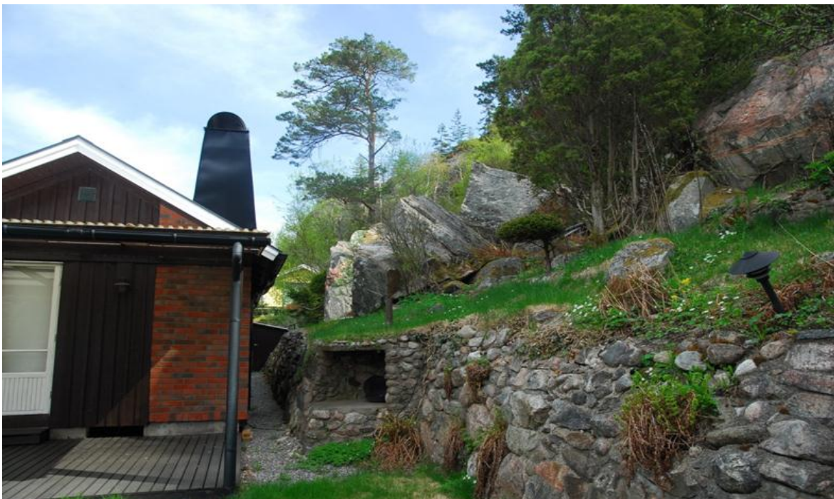
Bild 52. Högre upp mot fastighet 3:26. Stora lösa block, dock ingen risk för nedfall.
