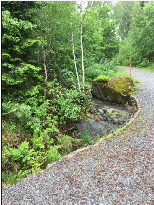
Bild 4 – Grusväg i området, där väggkanten stärkts upp mot bäckfåran.
