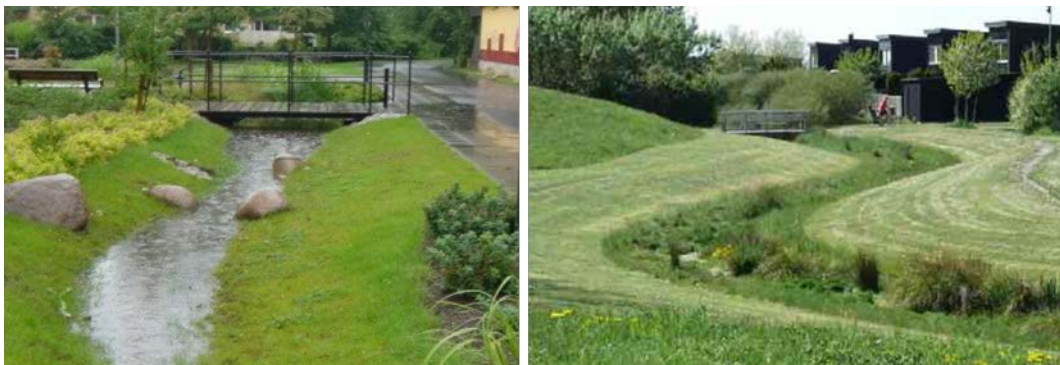
Figur 17. Augustenborg (t.v.) och Fjärilsparken, Malmö (t.h.) exempel på gräsklädda diken med flack släntlutning (Svackdiken). (VA-SYD, 2008)
