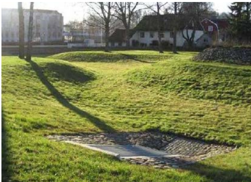
Figur 16. Yta för rekreation som tillfälligt kan svämmas över och användas för att fördröja dagvatten. (Härryda kommun, 2011)
