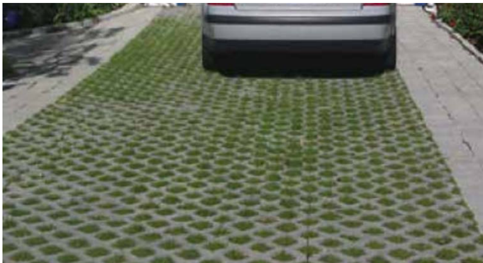
Figur 19. Genomsläpplig rasterbeläggning på parkeringsplats. (Uppsala vatten, 2014)
