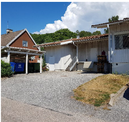
Befintlig lastkaj på Dingle 1:87
