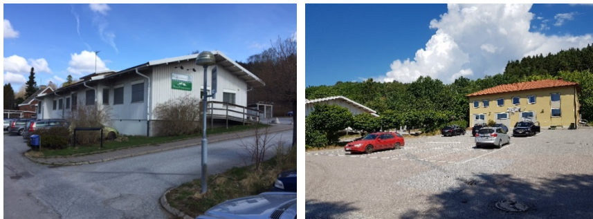
Veterinärbyggnaden (till vänster) och parkeringsytan framför den gamla brandstationen (till höger) ligger inom planområdet.
