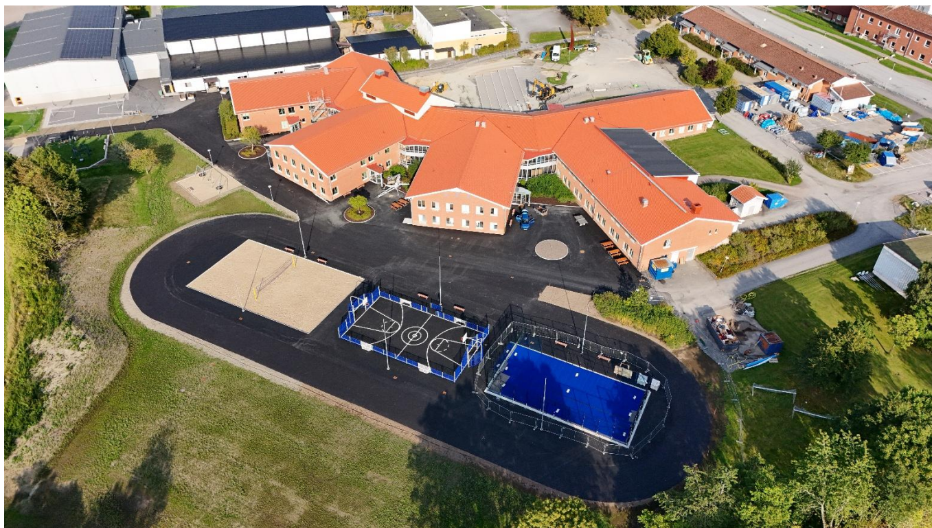
Kungsmarksskolan renoveras, september 2025. Foto: Erland Pålsson
