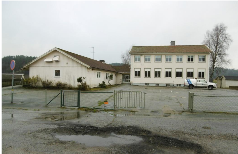
Skolbyggnaden sedd från vägen
